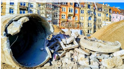
Reinigung, Stilllegung und Ausbau des Ölabscheiders des ehemaligen Autohauses
