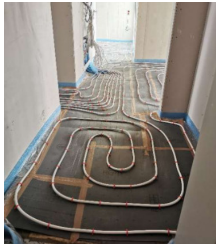
Fußbodenheizung
